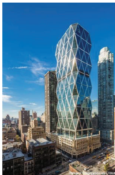
Hearst Tower/Arquitectura en acero
